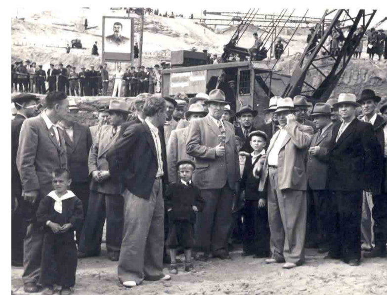
Первый куб! Закладка здания
