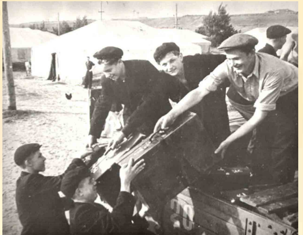
Прибытие рабочих на строительство Волжской ГЭС. 1950-е гг.
