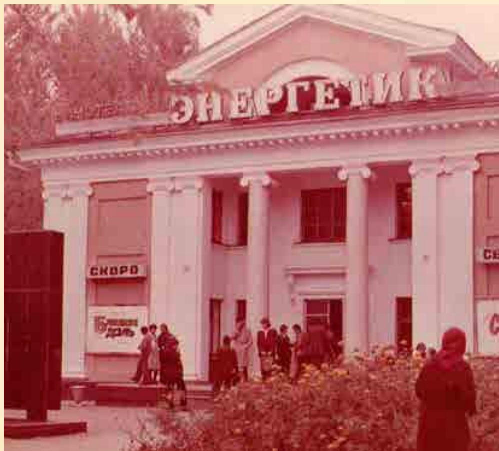
Кинотеатр «Энергетик». Памятник Ф. Г. Логинову – первому начальнику Сталинградгидростроя. 1976 г.
